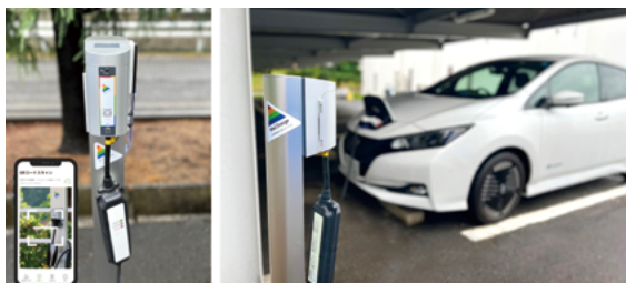
EV充電スマートプラグモジュール(上)をEV充電コンセント内に設置することで、EV充電課金サービスを実現
