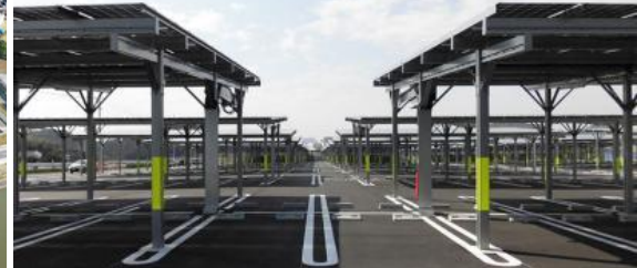
カーポートの屋根の上に設置された太陽光発電システム
