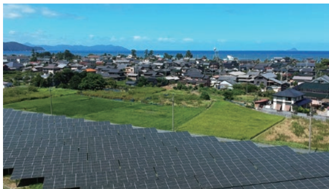
5万平方メートルに及び敷地面積に約2万枚のモジュールパネルを設置した太陽光発電所
